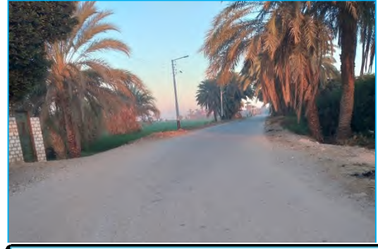
صورة (5) طريق طراد النيل ناظراً اتجاه الشمال المصدر : الدراسة الميدانية يوم الثلاثاء 2022/9/21م
