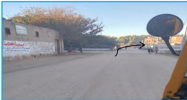
صورة (8) طريق مدخل الهامامية الغربي ناظراً اتجاه الغرب المصدر : الدراسة الميدانية يوم الثلاثاء 2022/9/21م
